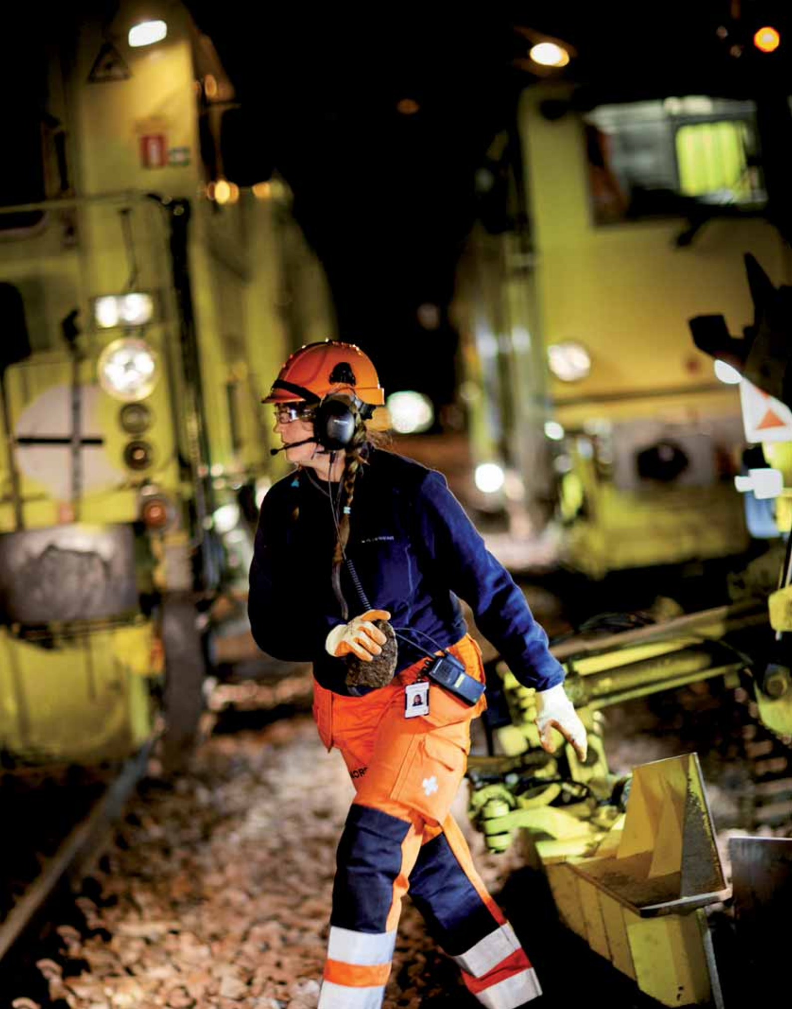
Transport- och infrastruktursektorn är väl representerad bland bolagen med statligt ägande. Här pågår nattligt spårarbete i Infranords regi. Foto: Infranord
