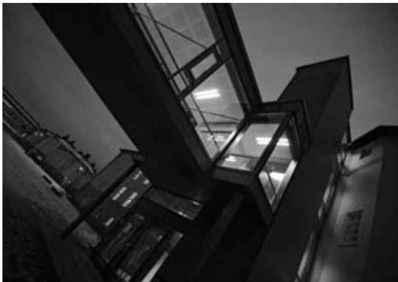
Det tidigare regementet P10 i Strängnäs ägs av Vasallen. Företaget bildades för att i samarbete med kommuner och lokalt näringsliv utveckla och förädla nedlagda regementen och andra försvarsfastigheter till attraktiva och levande stadsdelar för nya verksamheter. Foto: Vasallen
